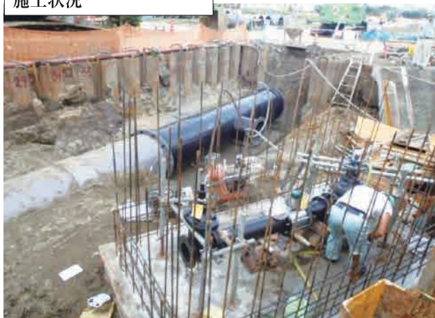
支線水路工事(1の1) 施工状況
