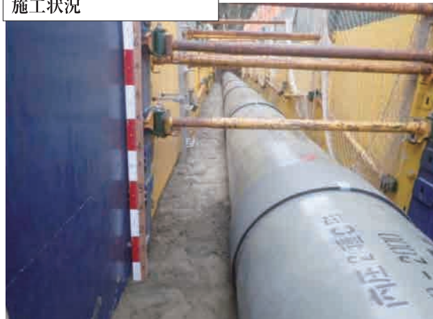
支線水路工事(6の11) 施工状況
