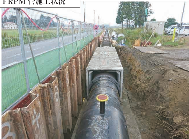
支線用水路3 FRPM管施工状況
