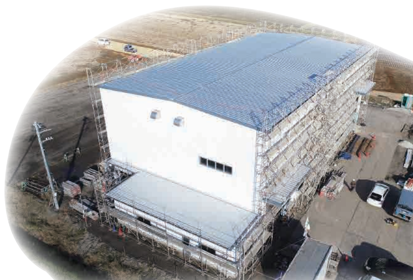
香取市 森戸地先（ライスセンター造成中）
