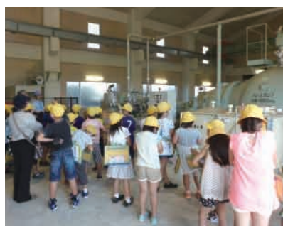
第1排水機場にて
