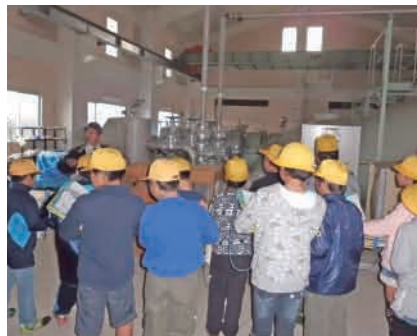
第1排水機場にて
