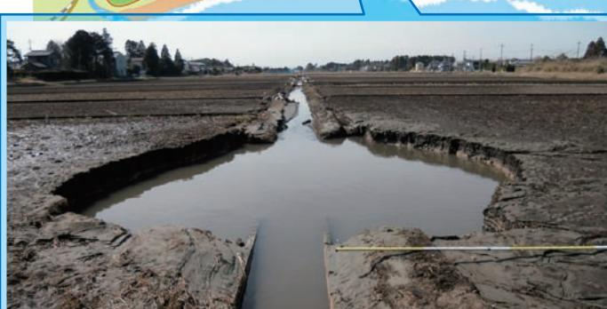
パイプライン破損による陥没（大網白里町桂山地先）
