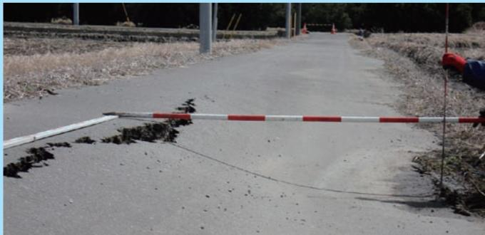
パイプライン破損による沈下（東金市広瀬地先）
