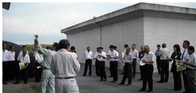
2 日 目 現 地 視 察 ( 第 1 排 水 機 場 )
