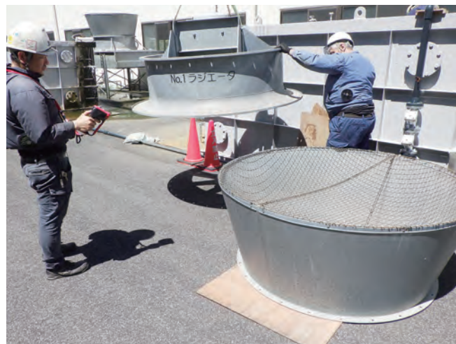
ラジエータの修繕工事 (第3揚水機場)
