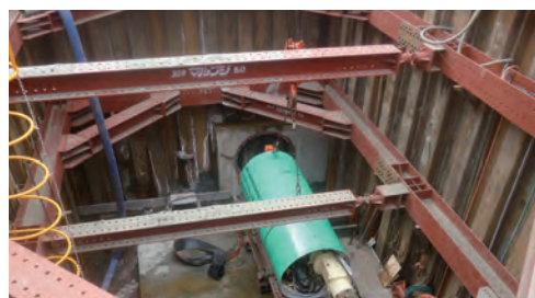
管の布設状況(推進工事)
